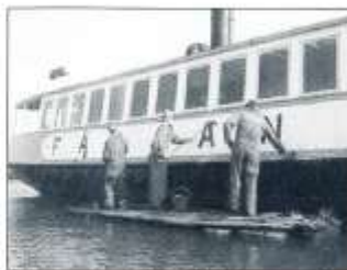
Några foton från Åke Karlsson från vårens arbeten med färjan. Väster sida: FÄRJAN 4 i docka vid Gøtenius varv. Nya plåten i B-strecket istycknad akterut. Övan: Vaskning av överbyggnaden från flotten vid Stormking på Ringön
