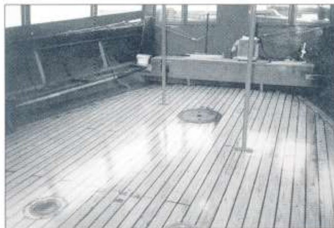
Däcket i kafeterian har under vintern genomgått en välbetäckt förvandling. Däcket har slipats, nåtats och lackats, rännstenarna i sidorna har lagts om och målats. Foto: Kennet Magnusson.
